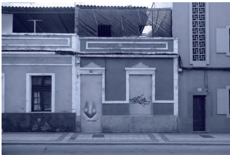
Foto 24. Casa terrera abandonada en Guanarteme-Plaza del Pilar, 2020 (Culturalink)
