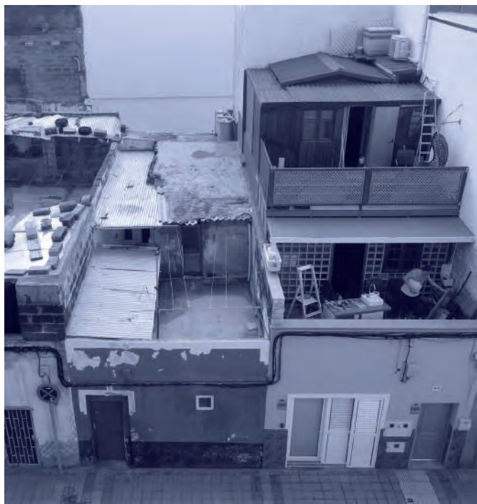
Foto 27. Viviendas en Guanarteme-Plaza del Pilar (Culturalink)
